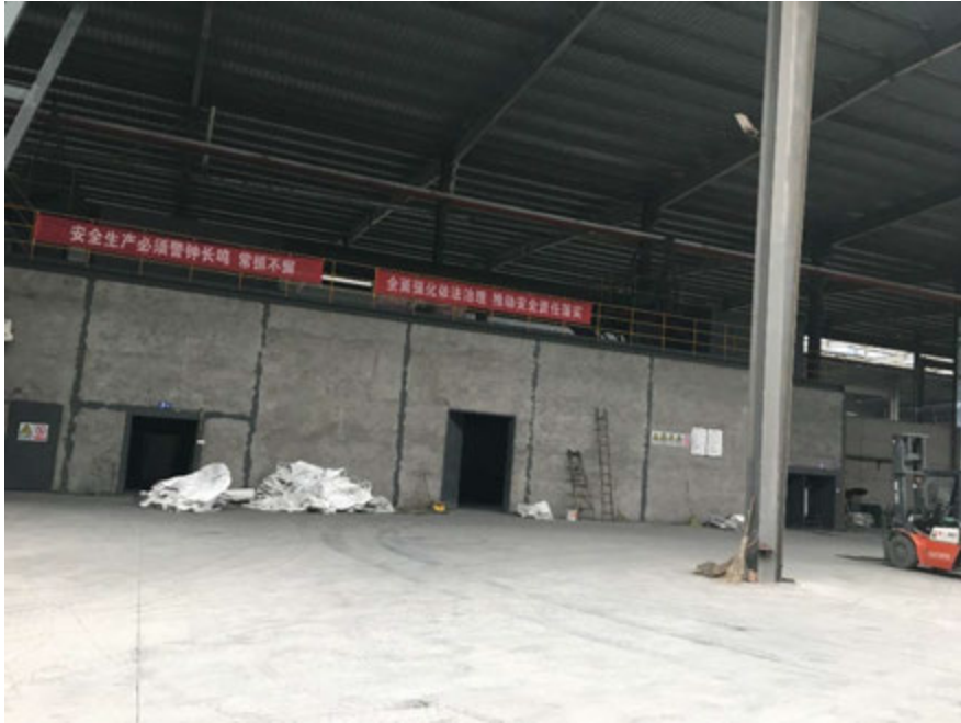
铝灰渣前处理线密闭隔声音和防尘措施
