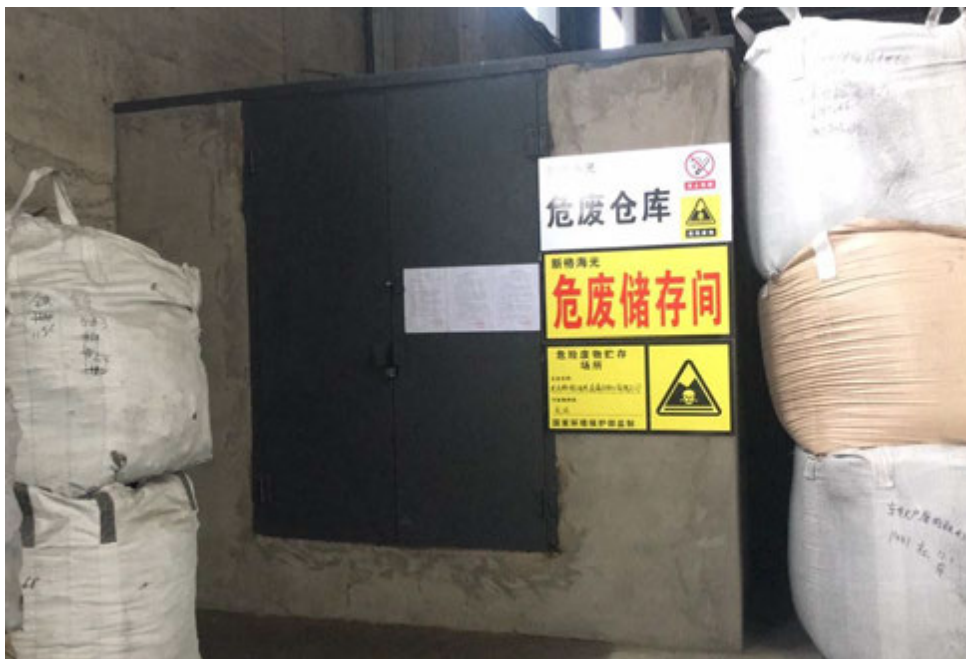
图 3.1-9 危险废物暂存间现场图
