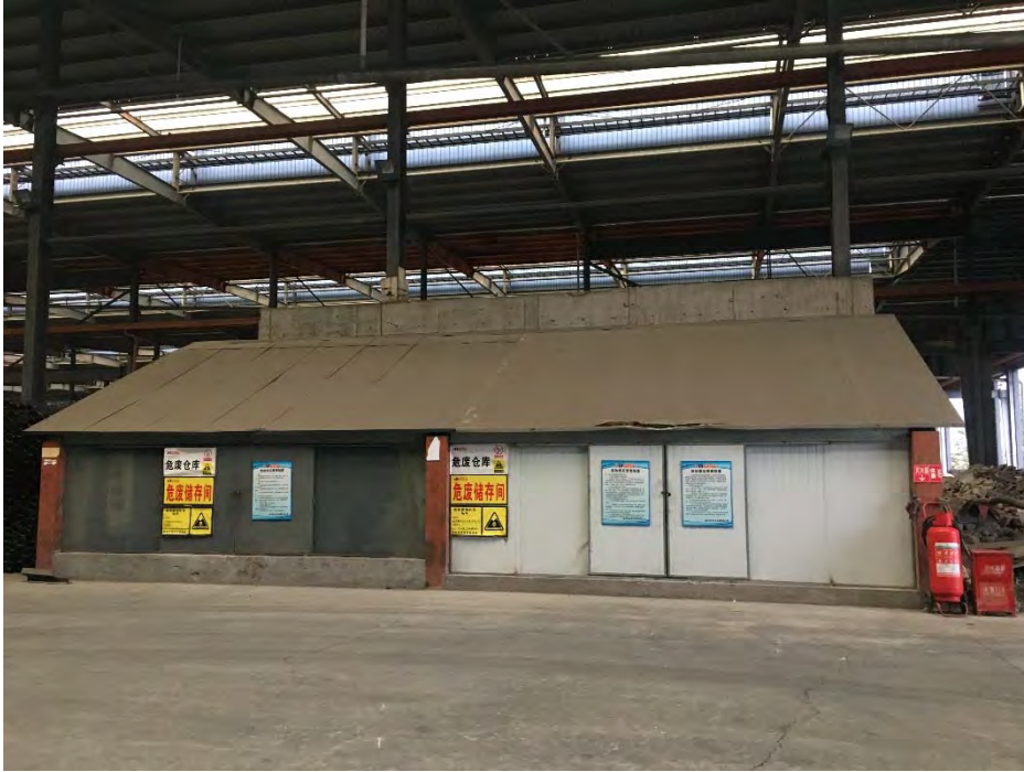
厂区危险废物暂存间
