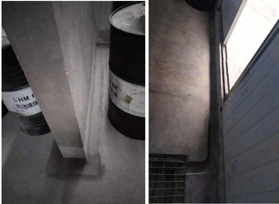
厂区危险废物暂存间（收集沟和应急收集池）
