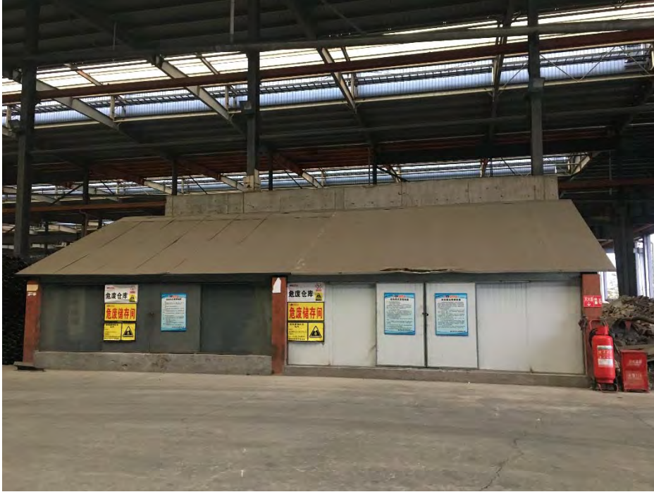
厂区危险废物暂存间
