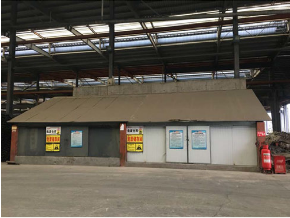
厂区危险废物暂存间
