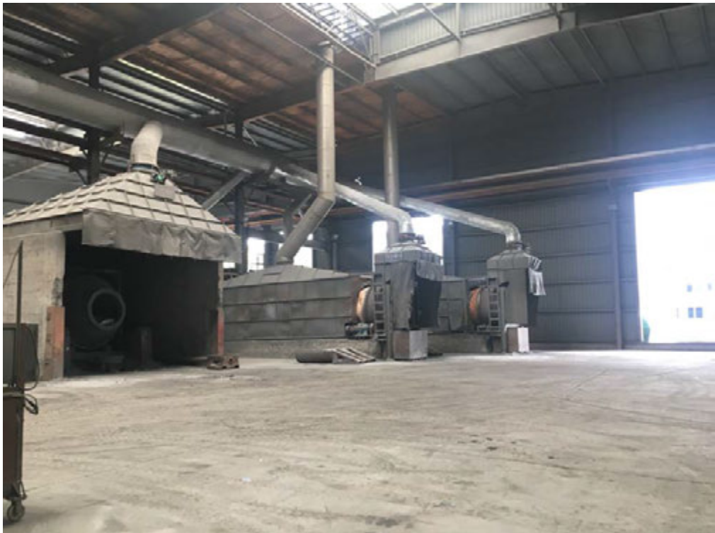
回转炉集气罩（部分示意）
