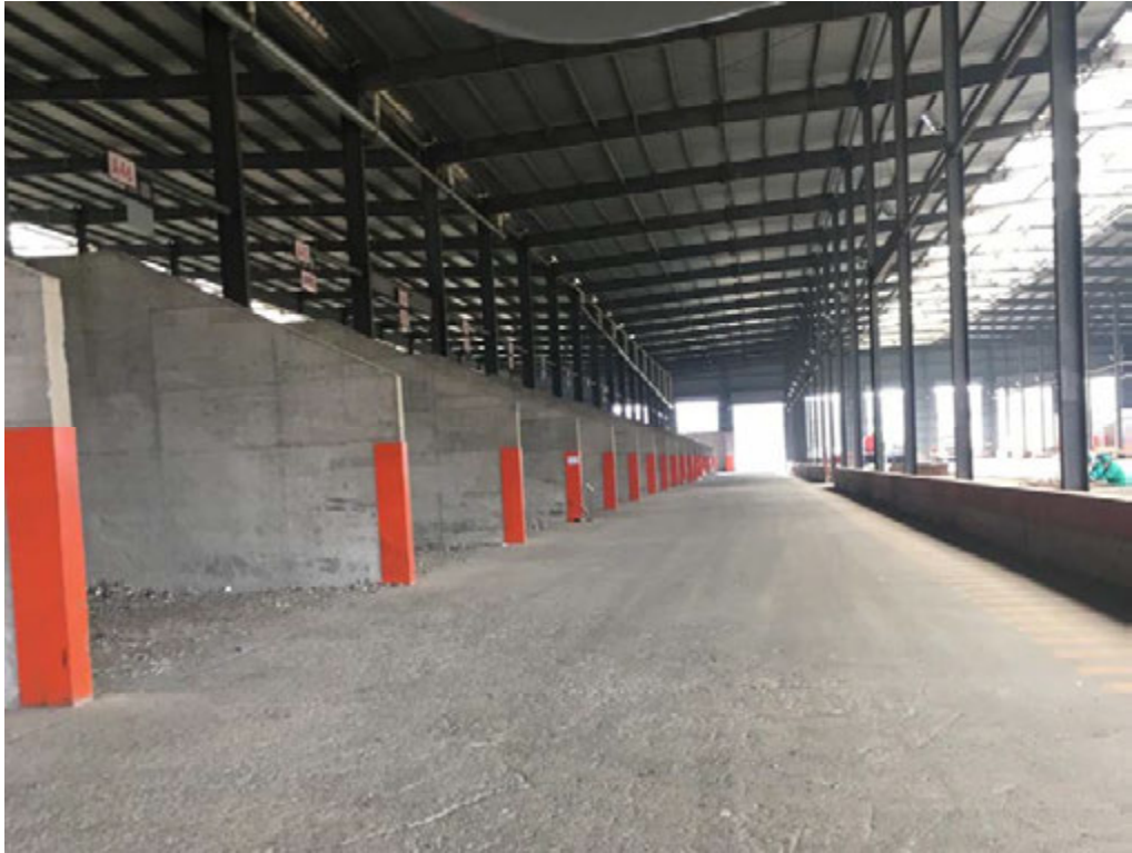
一般工业固体废物暂存区（废铁、废金属、非金属废渣等）
