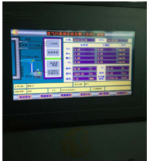
2#线排气筒 (DA002) 废气在线监测系统
