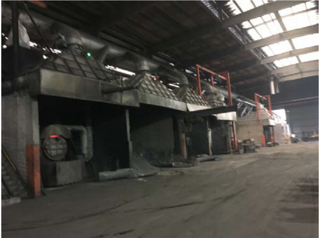
铝灰处理和回转炉集气罩+收集管网
