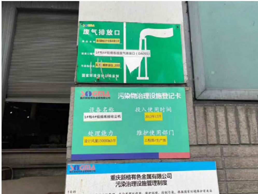
1#线废气排气筒 (DA001) 标牌 (示意)
