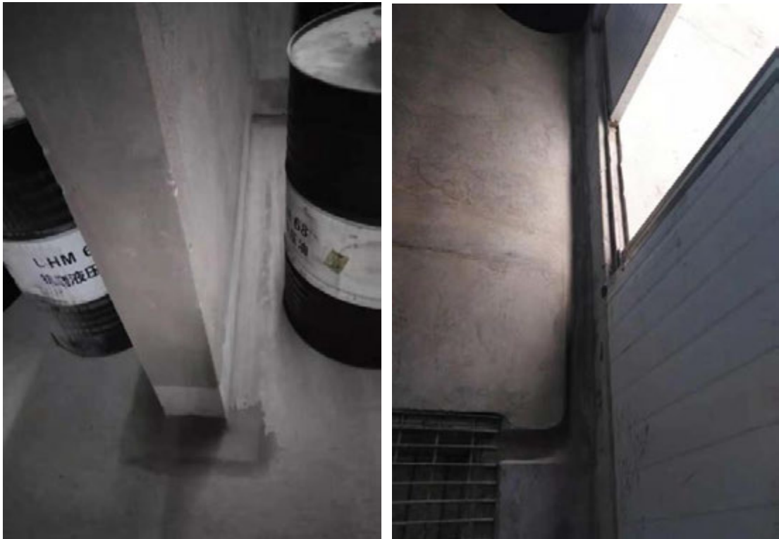
厂区危险废物暂存间分区防渗（收集沟和应急收集池）
