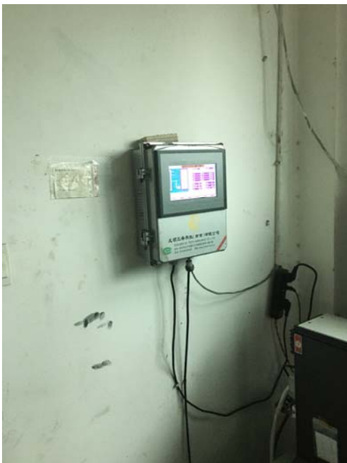
2#线排气筒 (DA002) 废气在线监测系统
