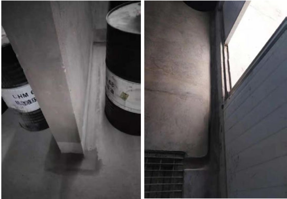
厂区危险废物暂存间（收集沟和应急收集池）
