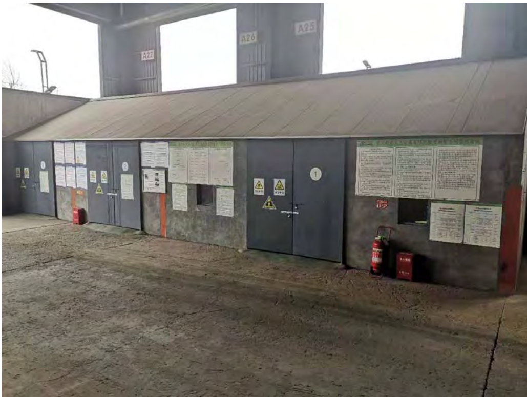
厂区危险废物暂存间
