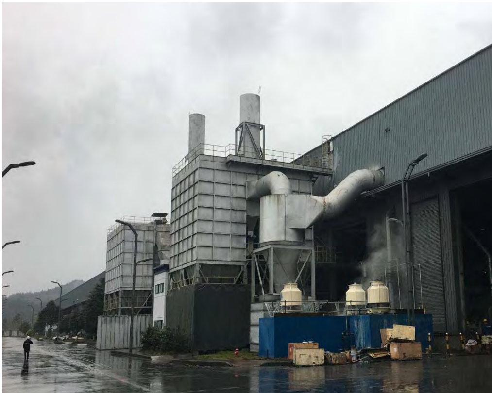
图 3.1-4 铝灰处理和回转炉旋风除尘+布袋除尘+排气筒（DA003）现场图
