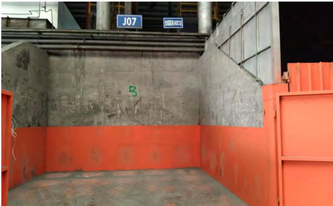
图 3.1-9 车间铝灰渣原料、中间产品、产品暂存区现场图（采用钢板作为防渗层）
