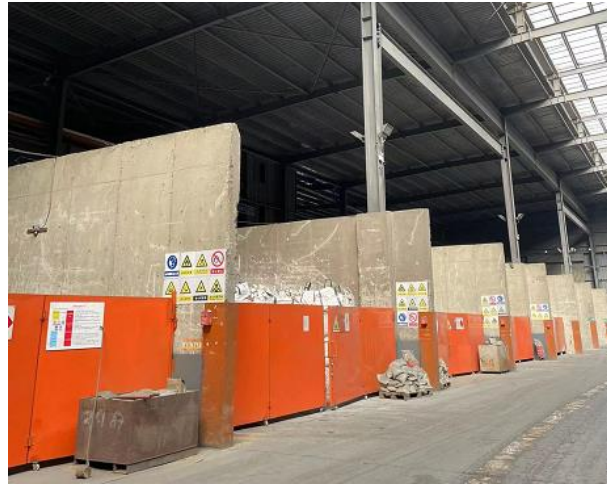
图 3-8 铝灰、除尘灰危废暂存间
