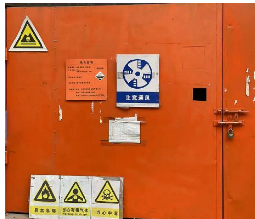
图 4 废酸危废暂存间
