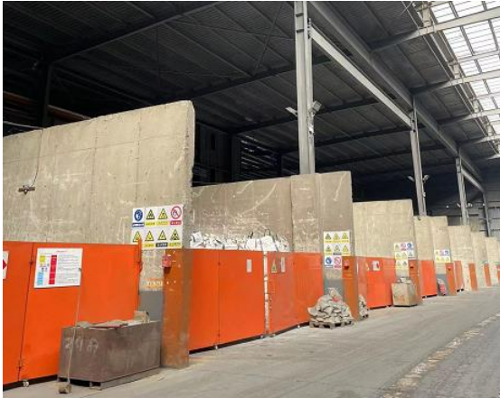
图 1 铝灰、除尘灰危废暂存间
