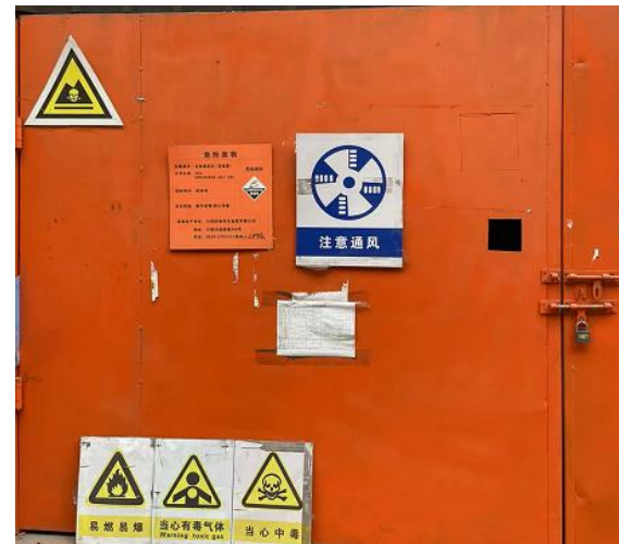
图 3-11 废酸危废暂存间
